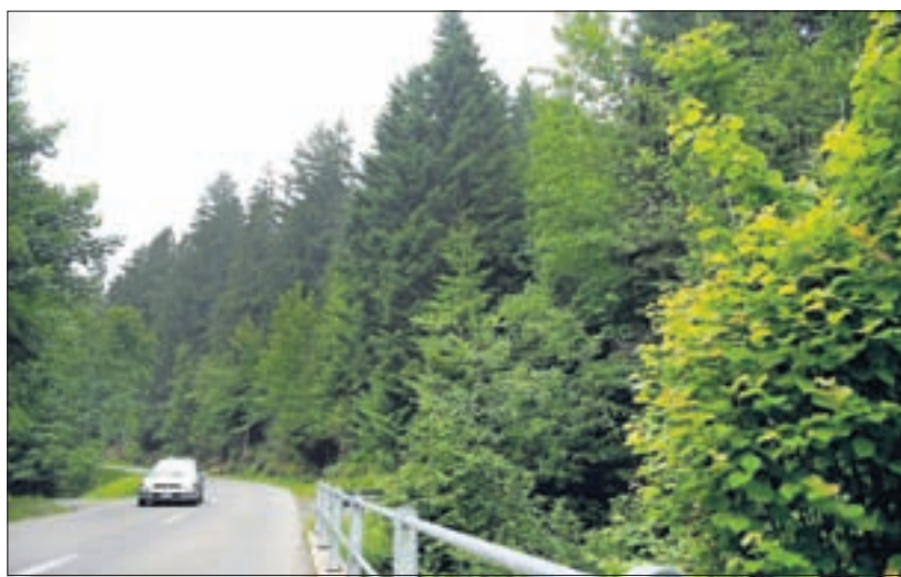
Im Gebiet Rischi sollen Wuhsteine für den Hochwasserschutz abgebaut werden.
